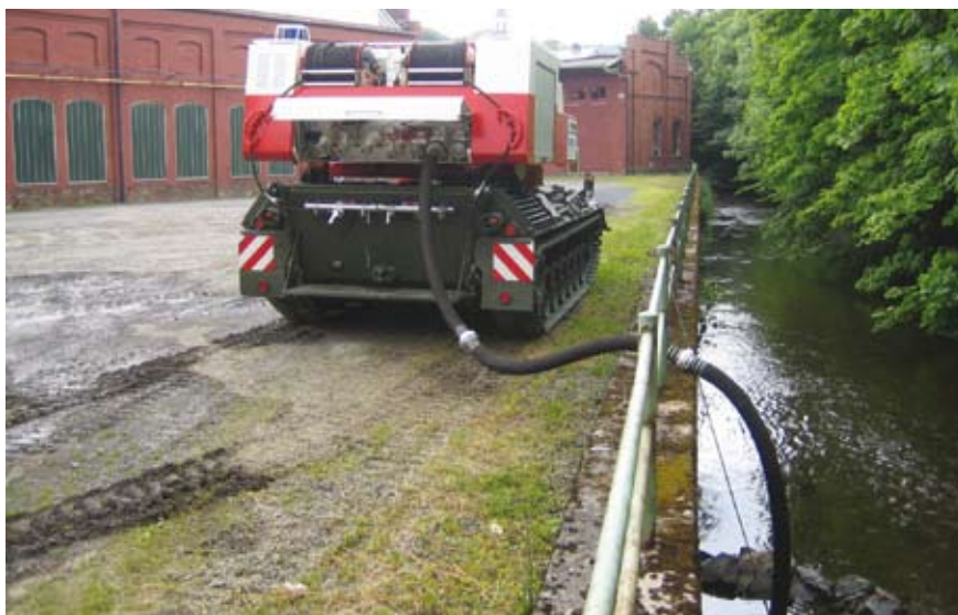
Füllen des Wassertanks durch Ansaugen aus offenem Gewässer
